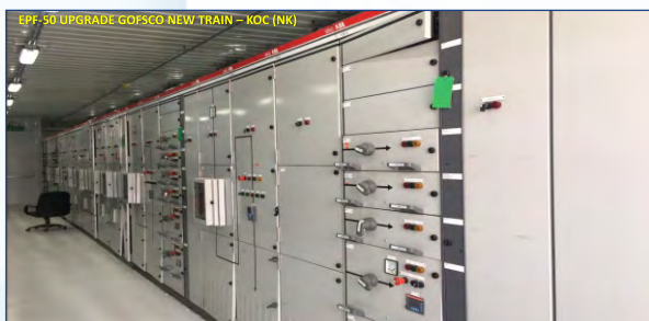
LV SWITCHGEARS
